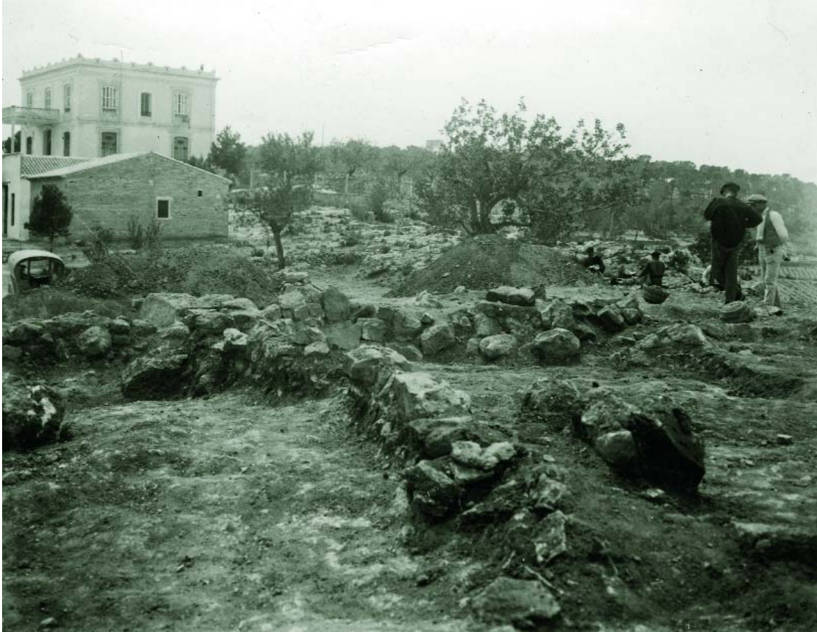
76. Vista de l'excavació en la Muntanyeta de Cabrera del Vedat (Torrent). 1931. [Placa de vidre. SIP 620]
